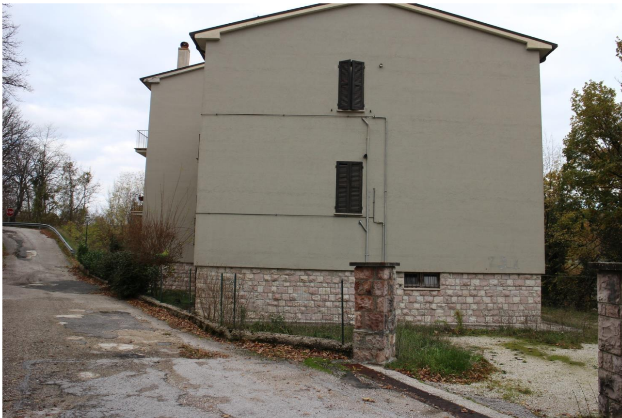
FOTO 2. PROSPETTO LATO SUD
